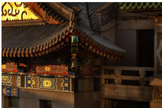
图 2 中式古建筑飞檐翘角结构
